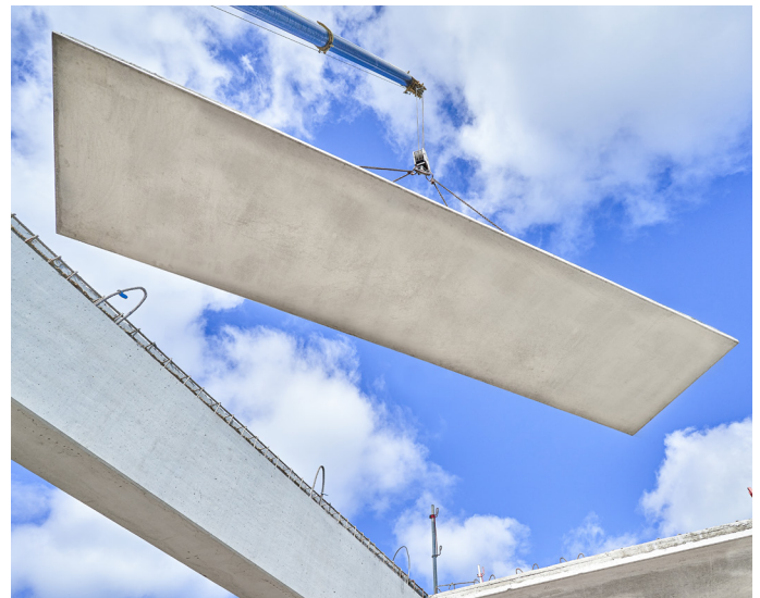
Montage einer Großformatplatte
