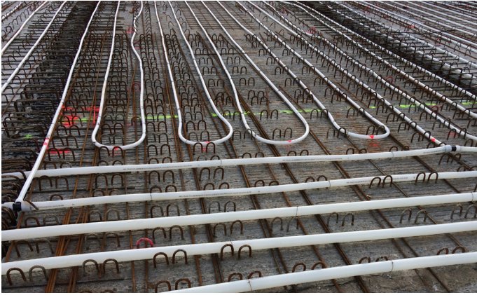
Betonkernaktivierung auf der S-dec® bauseits verlegt
