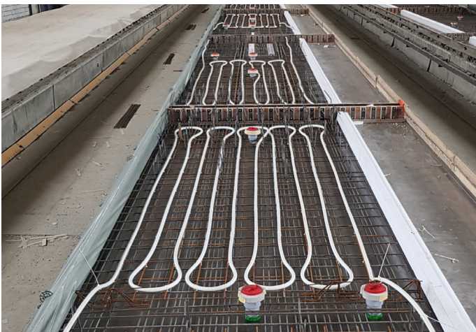
Betonkernaktivierung im Werk direkt eingebaut
