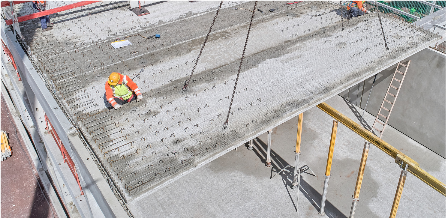
Montage bis 12 m mit Mittelunterstützung im Bauzustand
